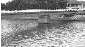
筈ノ川 来迎寺橋付近
