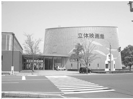
改修される立体映画館
